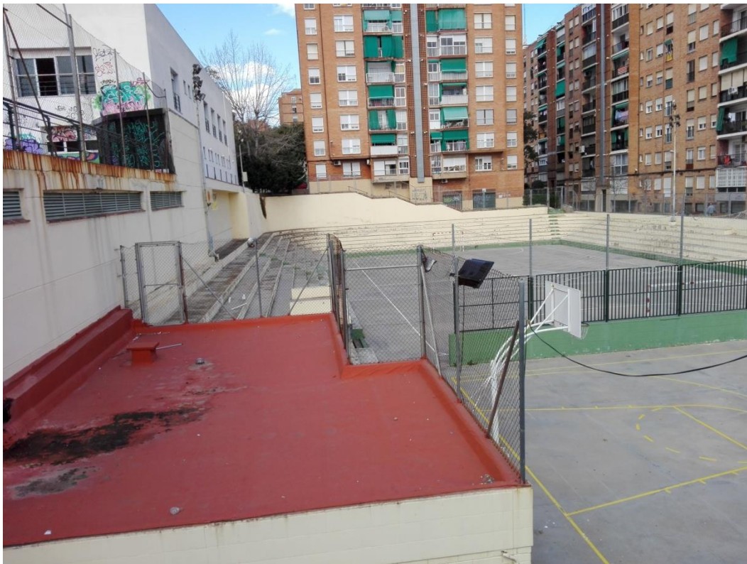
Vista de la coberta construcció annexa.
