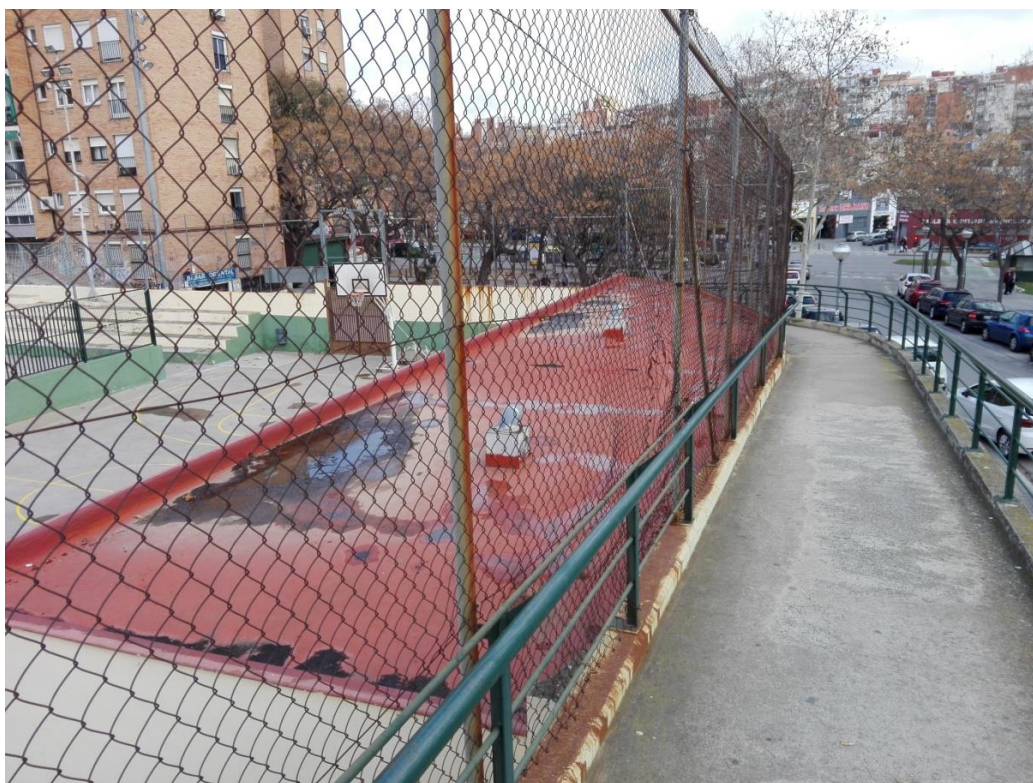
Vista de la coberta dels vestidors.
