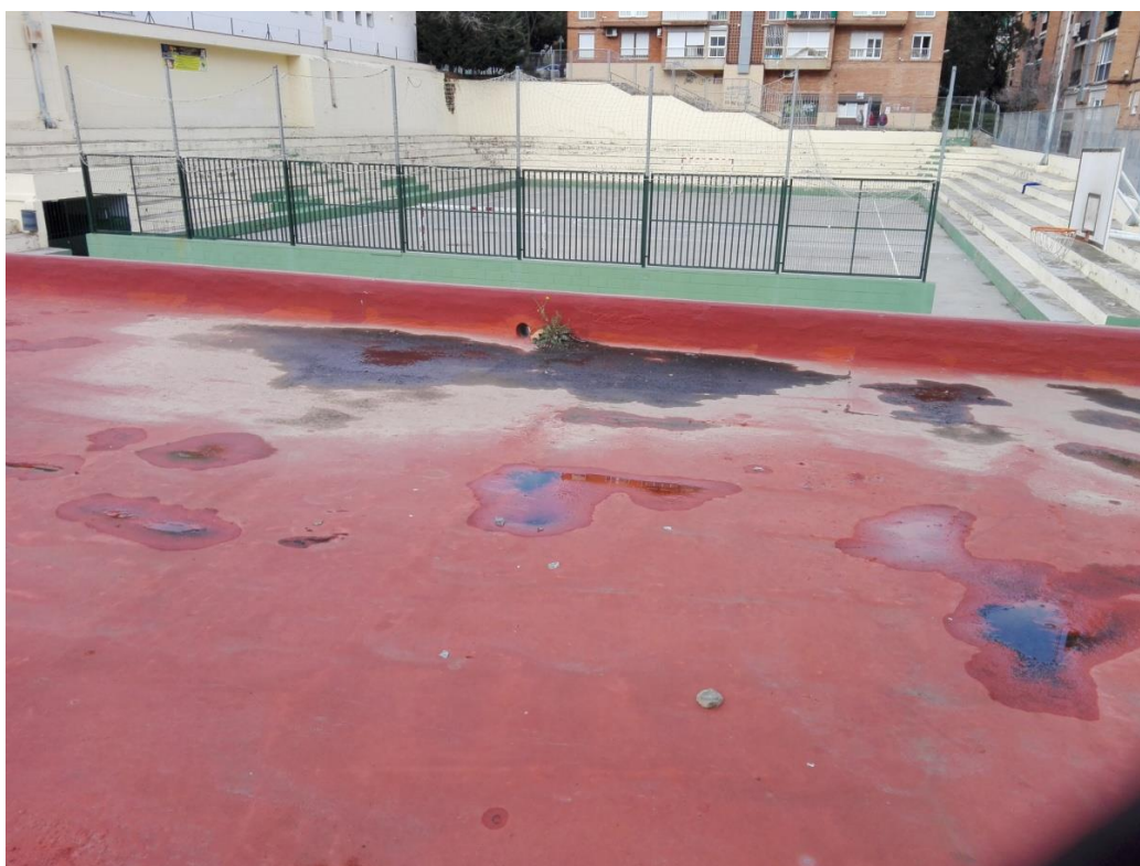
Punts d'acumulació d'aigua en la coberta.
