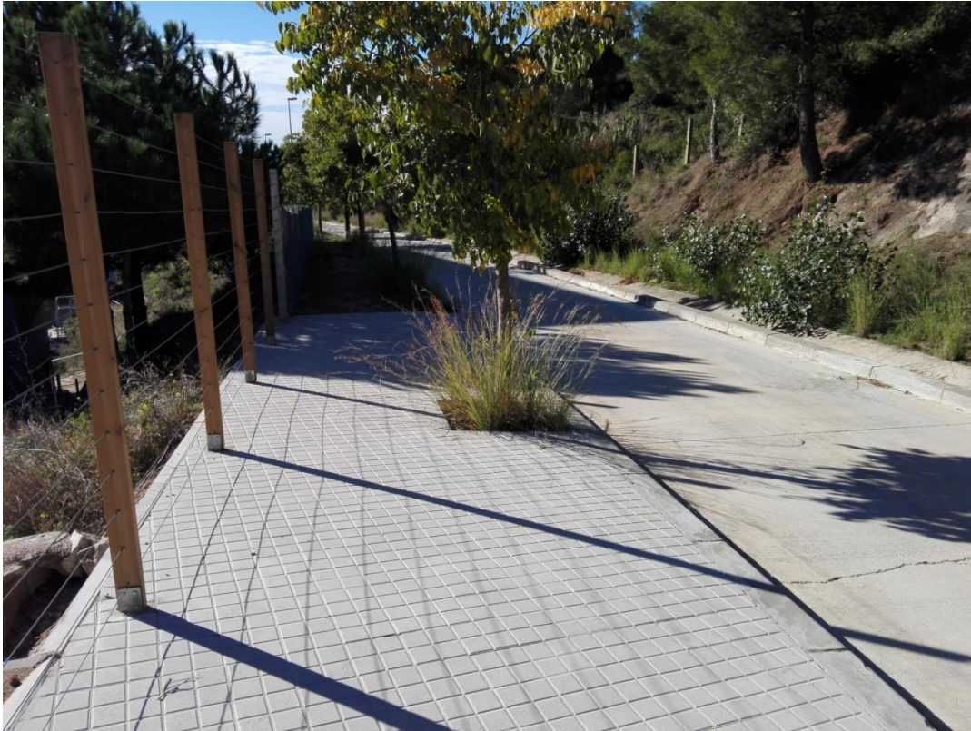
Punt de trobada amb la vorera existent en l'accés a l'estabulari
