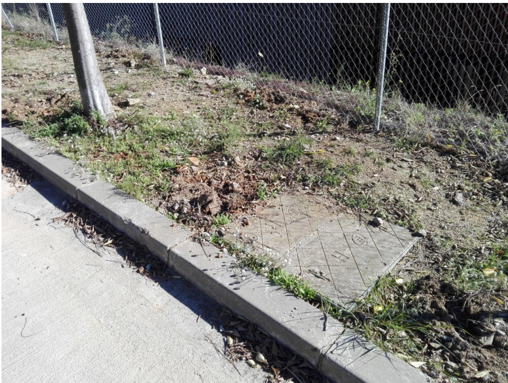
Arqueta de telefònica que s'ha de mantenir.
