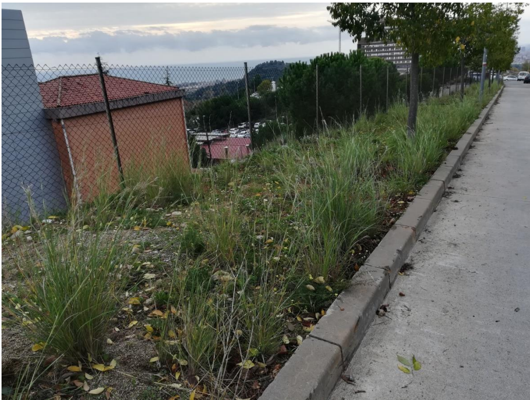
Vistes generals del traçat de la futura vorera.
