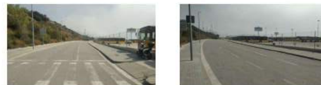
Imatge 11. Imatges de la futura ubicació de l'entrada i sortida de la cotxera al carrer dels Almogàvers.
