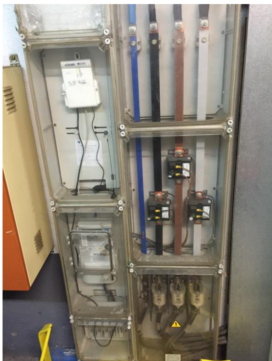
Comptador Edifici B
