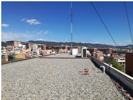
Coberta Edifici A – Vista 3
