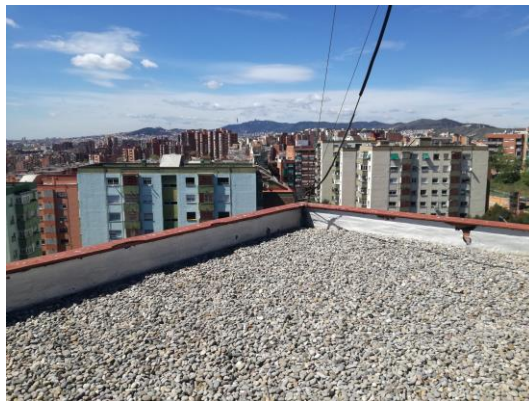
Coberta Edifici A – Vista 4
