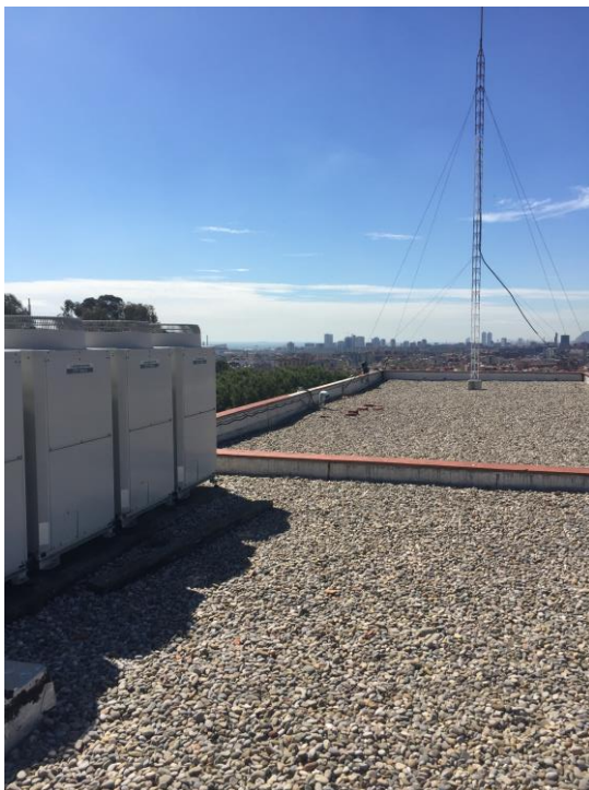
Coberta Edifici A – Vista 1
