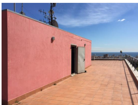
Coberta Edifici B – Vista 2
