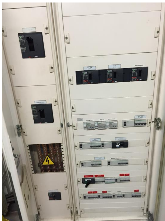
Quadre Electric Edifici B
