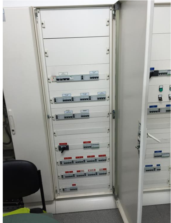
Quadre Electric Edifici A
