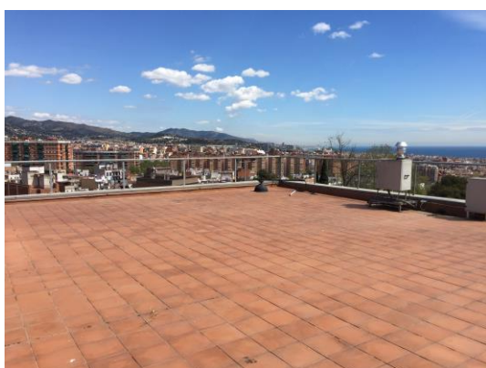
Coberta Edifici B – Vista 1
