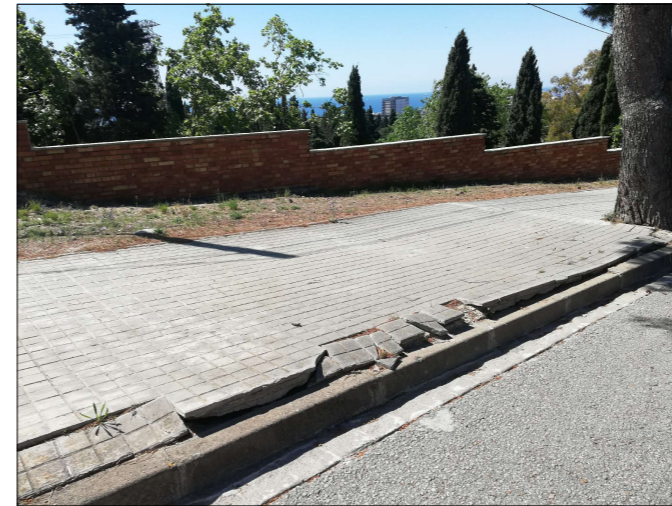
2. Paviment de vorera aixecat i trencat
