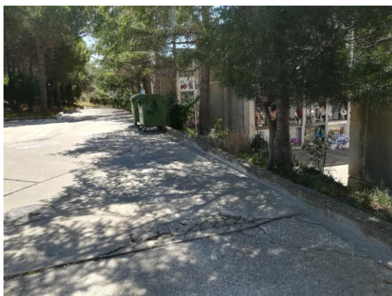
Zona d'aparcament que s'ha de reparar el paviment de formigó amb l'àrid vist.
