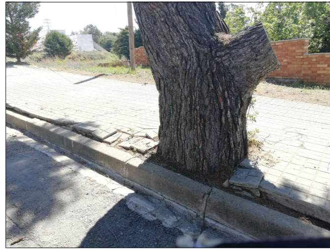
2. Paviment de vorera aixecat i trencat pels arrels
