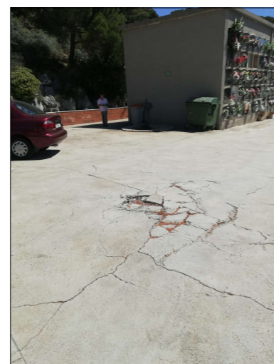
8. Paviment trencat i esquerdat
