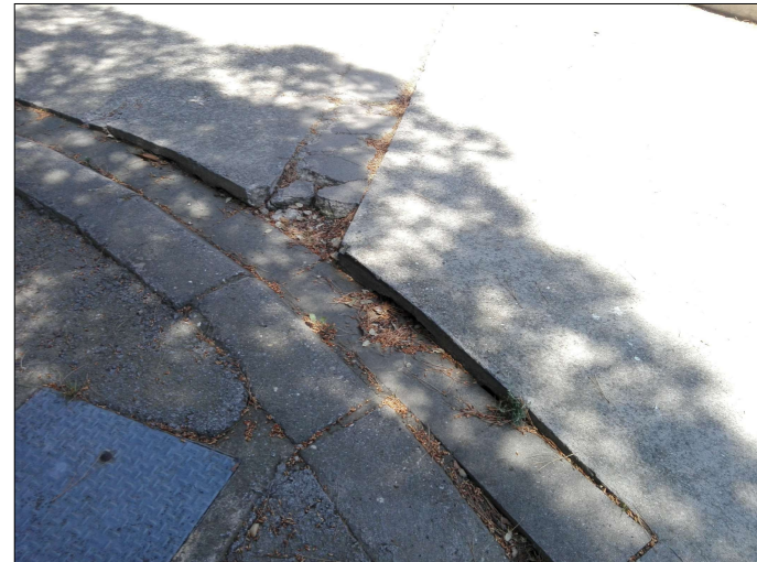
16. Paviment aixecat i trencat
