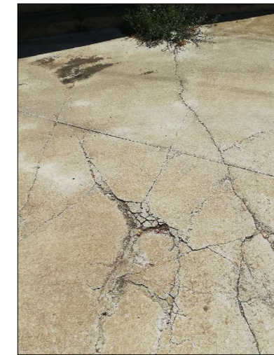
6. Paviment esquerdat
