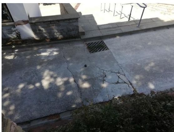
Punt de reparació de paviment en un dels carrers.
