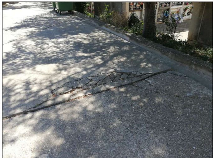
15. Paviment trencat i aixecat
