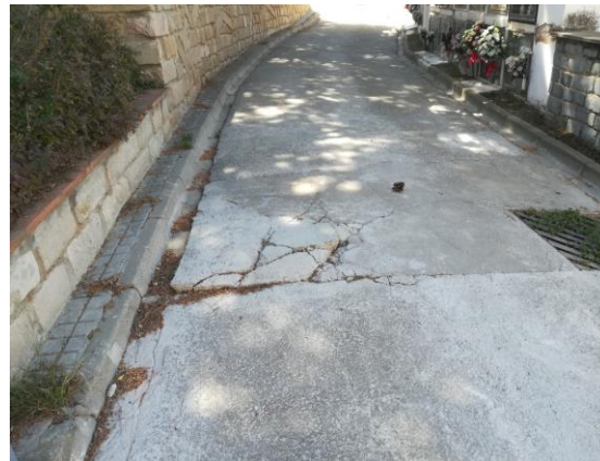
Punt de reparació de paviment en un dels carrers (mateix foto anterior)
