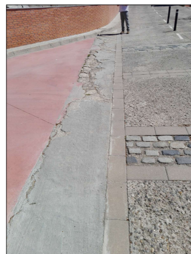
7. Manca de paviment
