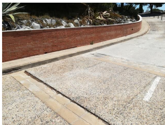
Zona de carrer que s'ha de reparar el paviment amb formigó amb l'àrid vist.
