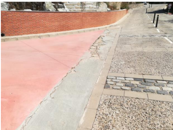
Zona en que s'ha de reparar el paviment amb formigó de color.
