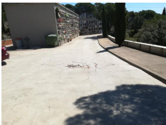
Zona d'aparcament que s'ha de reparar el paviment de formigó.
