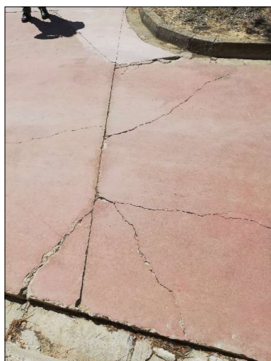
7. Paviment esquerdat i aixecat
