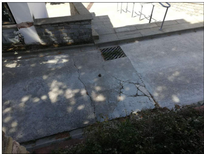
4. Paviment de formigó trencat i reixa bruta
