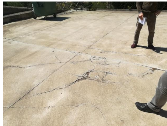
Zona d'aparcament d'un dels carrers que s'ha de reparar el paviment de formigó.
