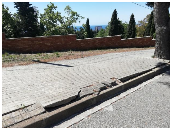
Zona d'accés al cementiri en que s'ha de reparar la vorera.
