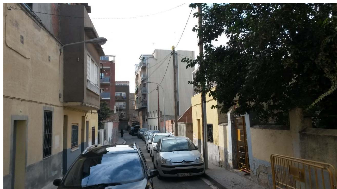
Carrer Numància vista general
