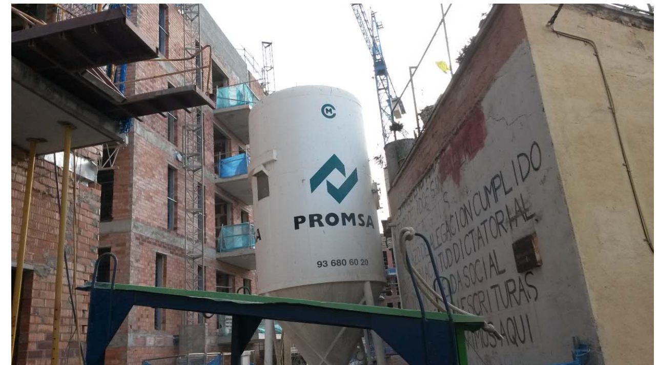
Carrer Numància. Límit del solar pel futur equipament amb els edificis de nova construcció
