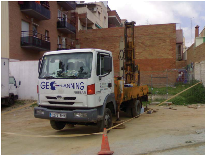
Emplazamiento sondeo S.6.
