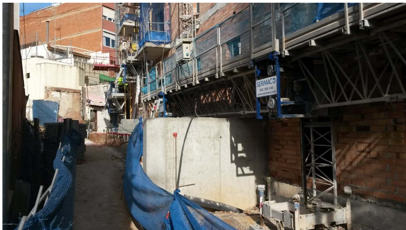
Límit del solar pel futur equipament amb els edificis de nova construcció
