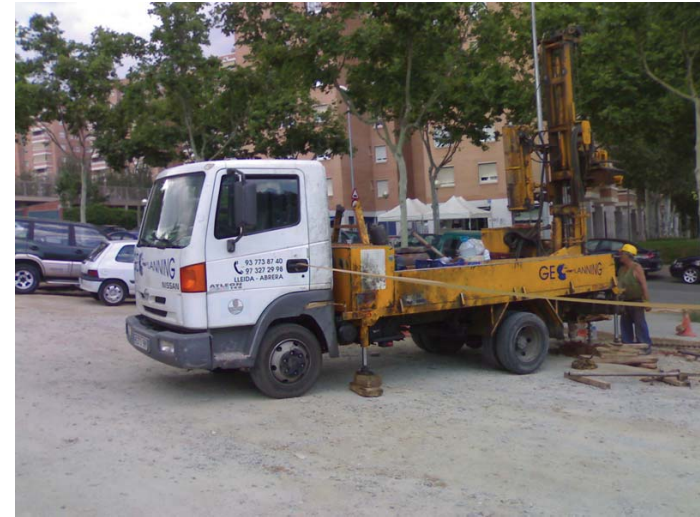
Emplazamiento sondeo S.4.
