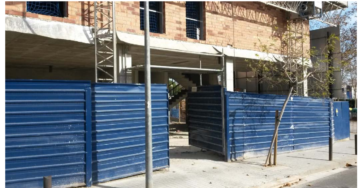
Accés pàrquing nous edificis al carrer Marià Benlliure
