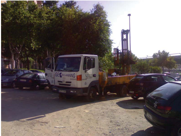
Emplazamiento sondeo S.4
