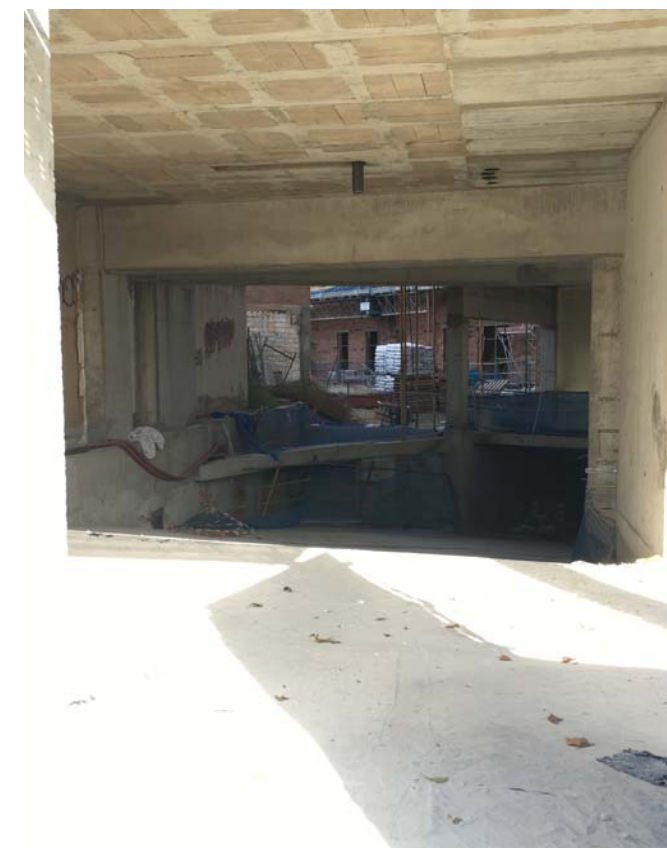
Rampa accés pàrquing nous edificis, illa interior.
